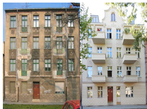
Vorher Nachher Rekonstruierte Fassadenelemente (Balkonanlagen und Frontspieß)
