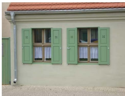
Klappläden mit Leibungskästen an einem Kolonistenhaus
